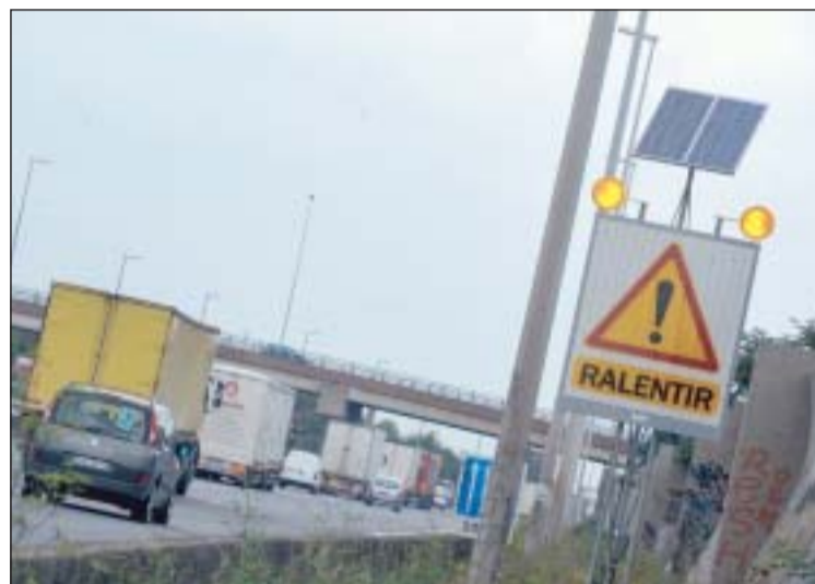
Petite touche écolo : les panneaux et radars, dotés de capteurs solaires, sont autonomes en énergie.
