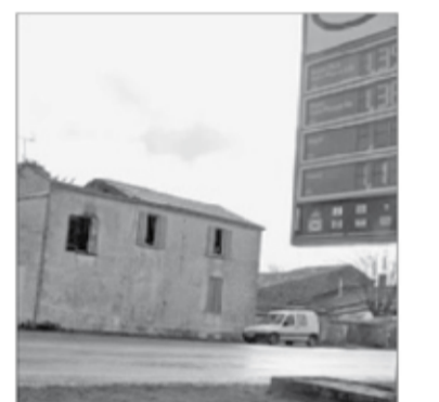
Les flammes ont ravagé près de la moitié de l'habitation. PHOTO COLETTE MACHTOS
