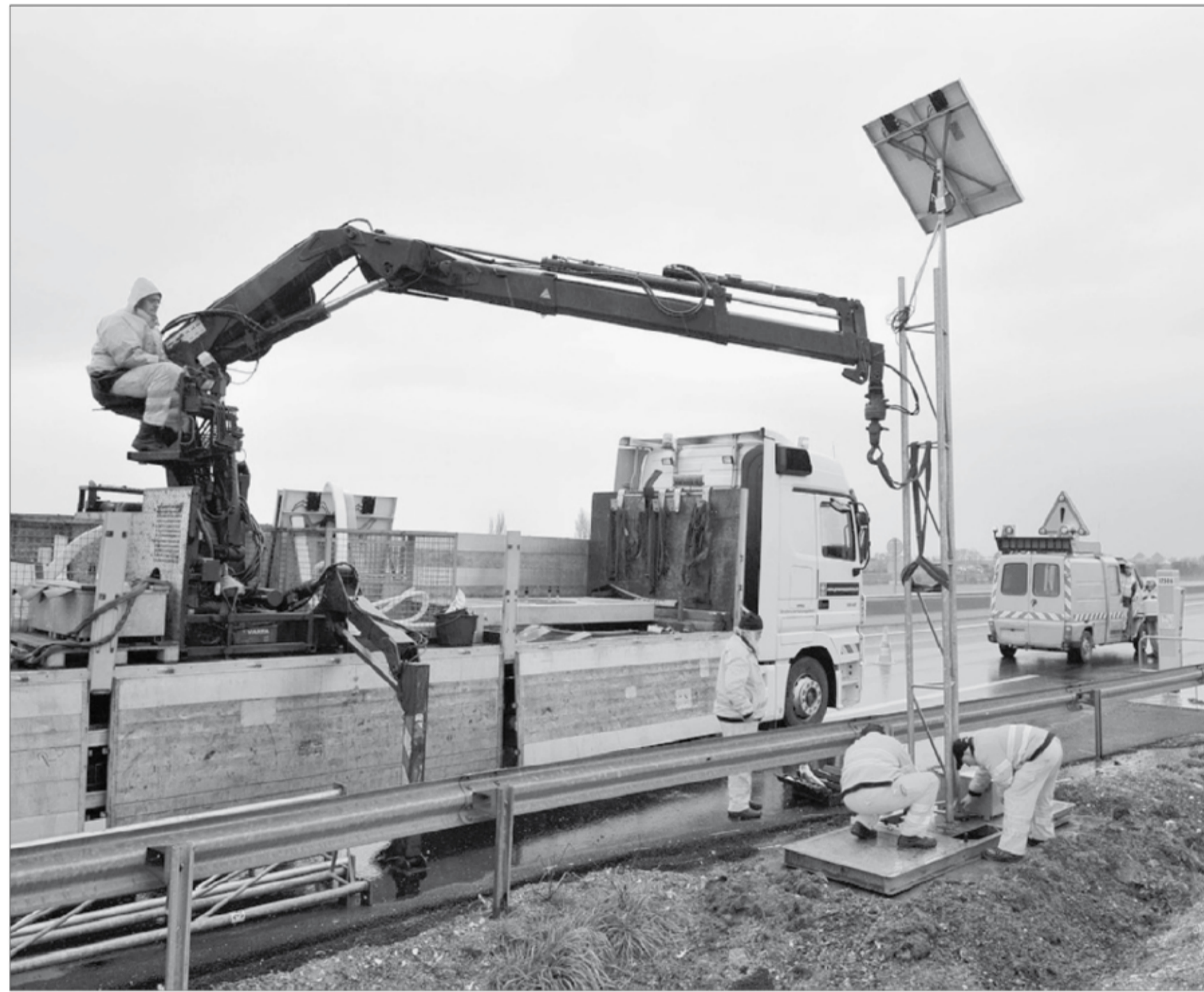
Hier matin, sur la rocade rochelaise. Les techniciens allemands installent des panneaux de signalisation à messages variables. PHOTO XAVIER LÉOTY
