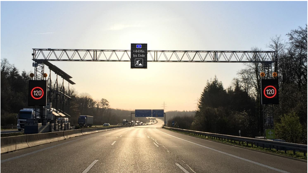
Abbildung: Anzeigequerschnitt iStWA A8 FR München (Quelle: Green Way Systems GmbH)
