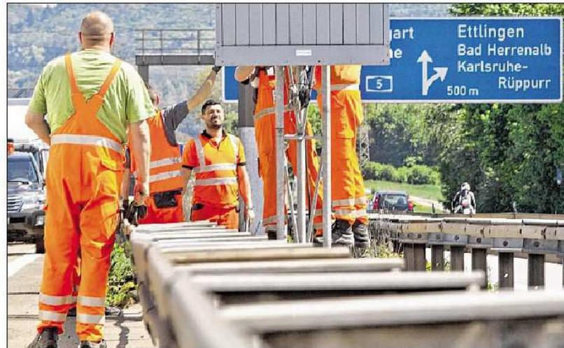
PER FUNK GESTEUERT werden die mobilen Stauwarnanlagen, die wegen der neuen Großbaustelle gestern auf der A 5 bei Karlsruhe installiert wurden. Foto: Fabry
